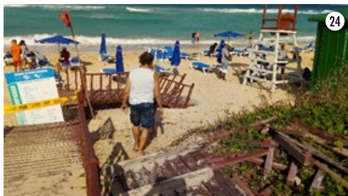
Fig. 24. Tránsito de personas por los laterales de la pasarela central dado el pésimo estado constructivo de la misma
