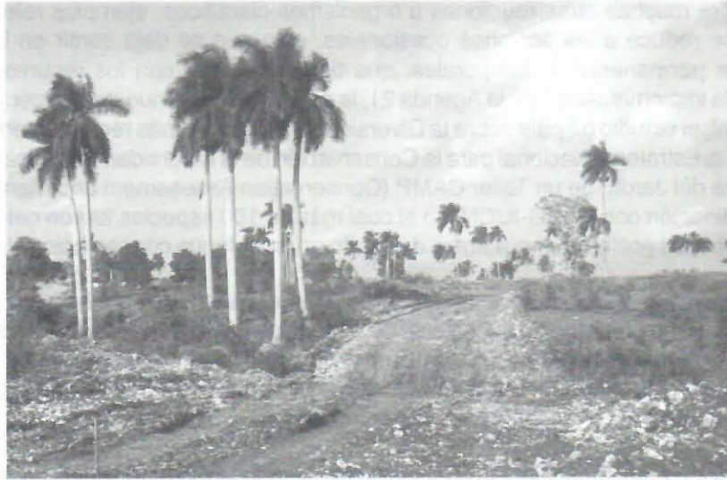
Vista del Jardín al iniciarse la construcción de los caminos interiores.
