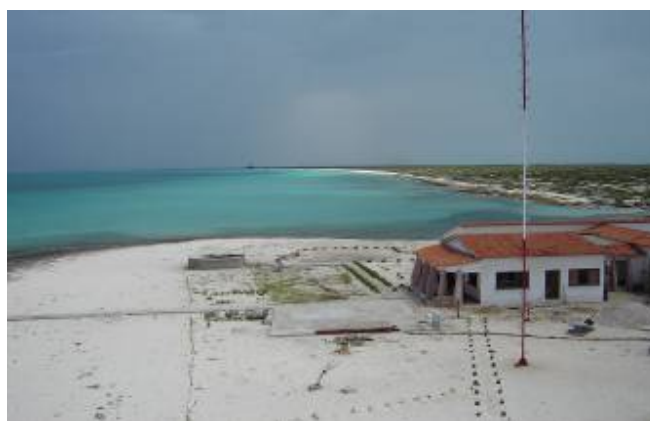
Fig. 8. Instalaciones de servicio fuera de la playa.
