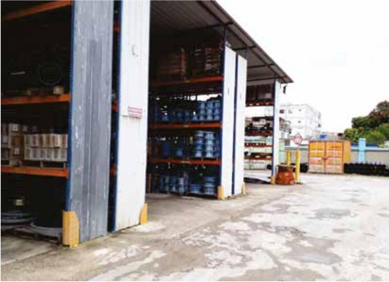
**Fig. 3.3.** Nave autoportante “convencional” abierta.
