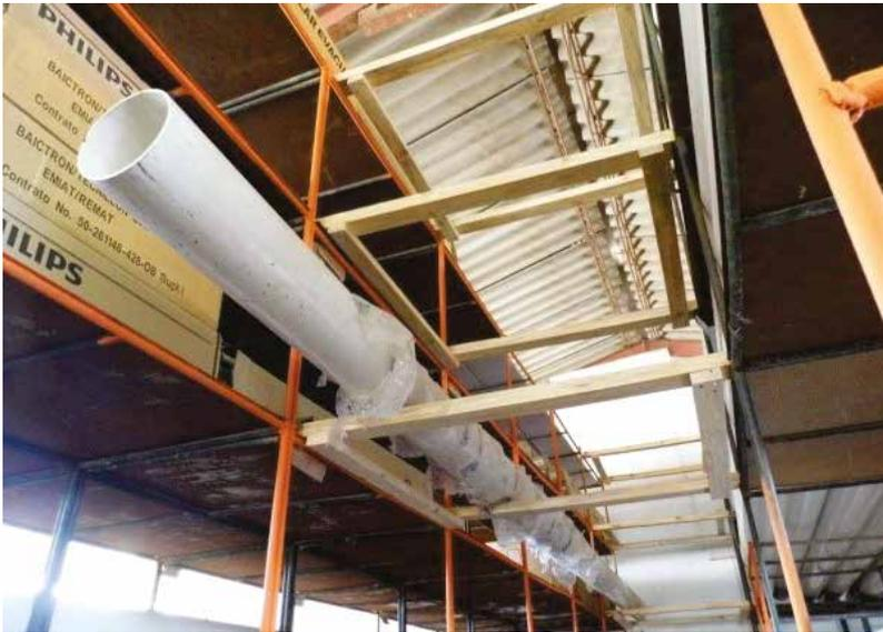
**Fig. 2.15.** Cunitas tecnológicas de madera para cargas largas en la parte superior del pasillo de trabajo.
