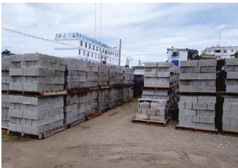
**Fig. 3.9.** Almacenamiento de bloques unitarizados sobre paletas recibidos así del proveedor.
