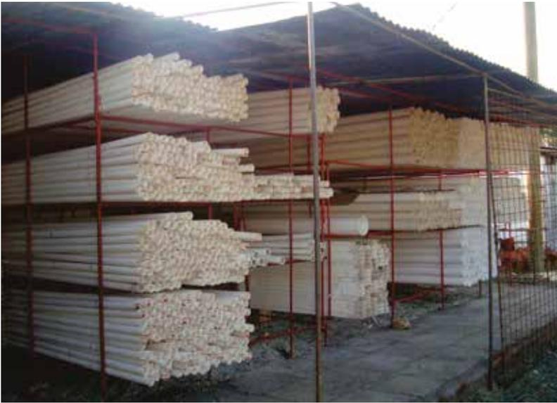
**Fig. 2.31.** Nave autoportante en construcción para el almacenamiento de cargas largas, en este caso tuberías plásticas
