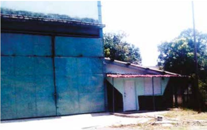
**Fig. 2.30.** Un ejemplo de una oficina fuera del almacén que permite un mejor flujo tecnológico y mayor capacidad de almacenamiento.
