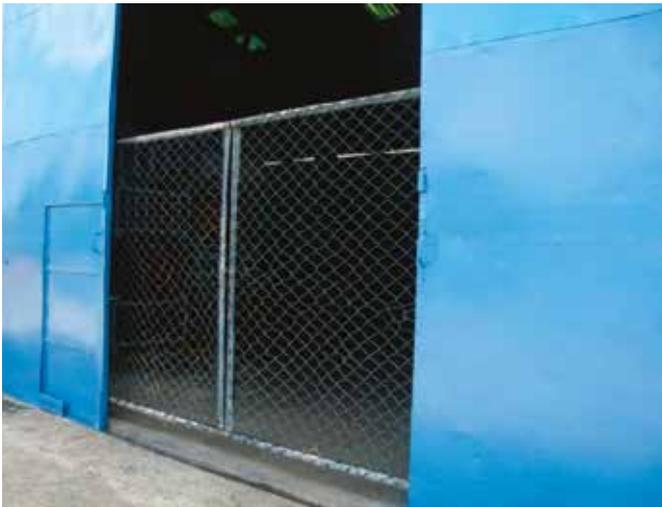
**Fig. 2.24.** Puerta de malla adosada a la pared del almacén o a su puerta.
